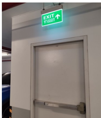
ภาพที่ 5-25 ประตูหนีไฟ และป้ายทางออกฉุกเฉิน
