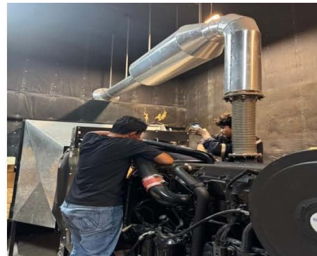
ภาพที่ 5-3 ห้องเครื่องไฟฟ้าสำรอง ดูแลตรวจสอบ และทดสอบให้อยู่ในสภาพดีพร้อมใช้งาน
