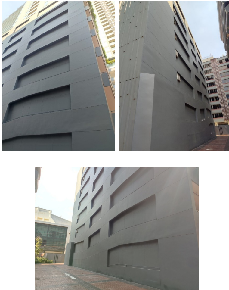
ภาพที่ 5-51 ปรับปรุงผนังอาคารจอดรถด้านทิศใต้ของอาคาร เป็นผนังกันเสียง ปิดทับป้องกันผลกระทบด้านเสียงจากอาคารจอดรถ ไปยังอาคาร ฟิเอสเจ อพาร์ทเมนต์ และอาคาร โรงแรม คราวน์ บีทีเอส นานา
